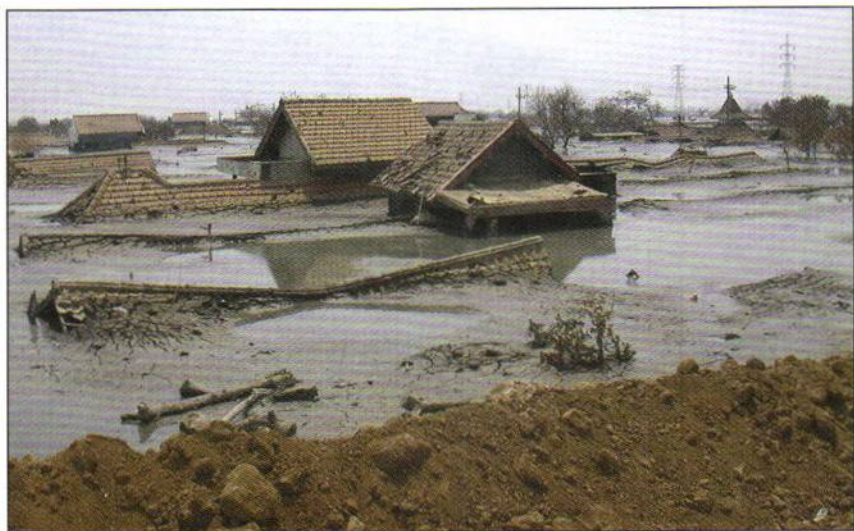
Такие разрушения причиняют «слабые» ответвления селевого потока
