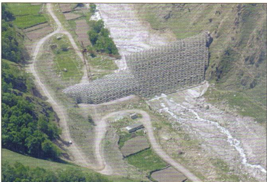
Строительство селезащитной плотины в Кабардино-Балкарской республике
